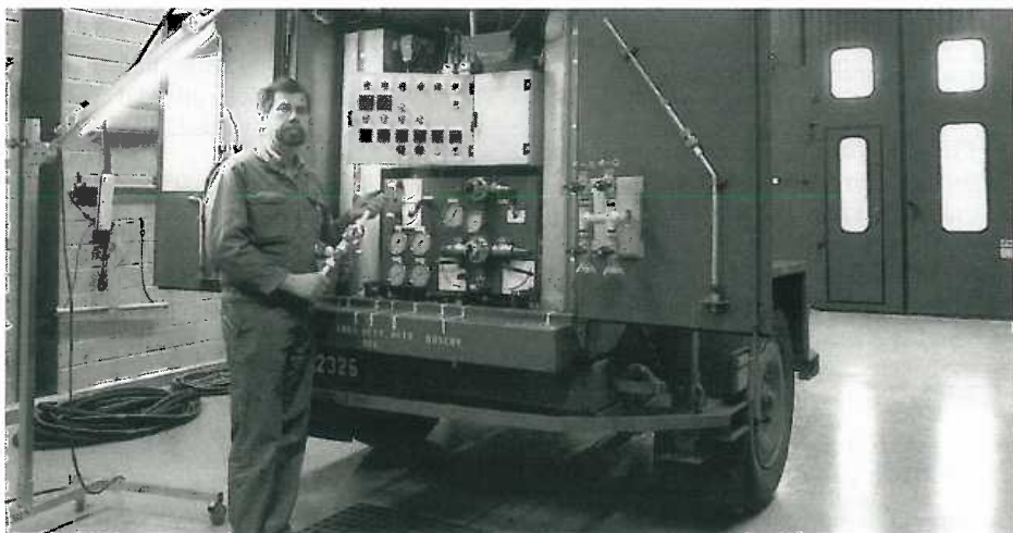
Ulf Andersson utför TS på ett ång- och kylvattenaggregat.
